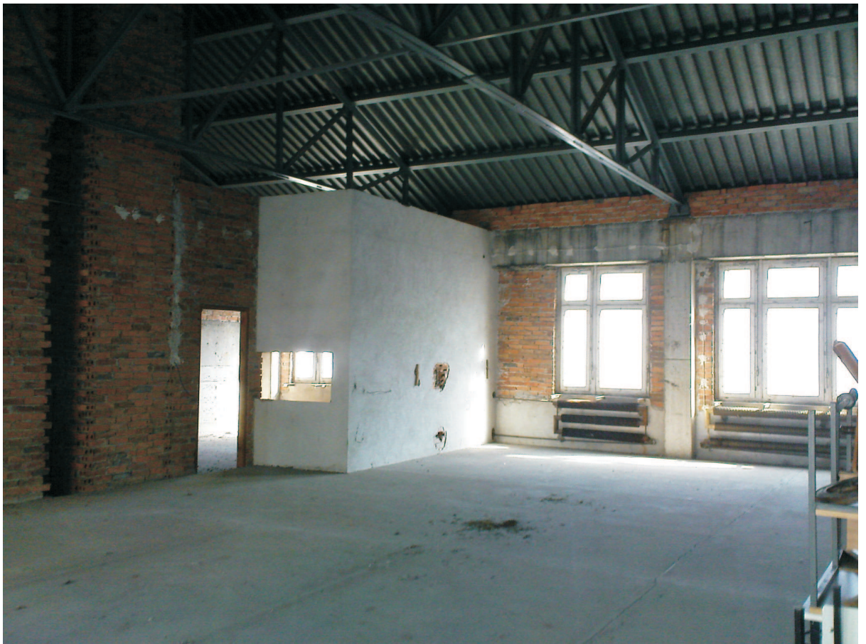
JADALNIA - WIDOK NA WEJŚCIE DO KUCHNI
