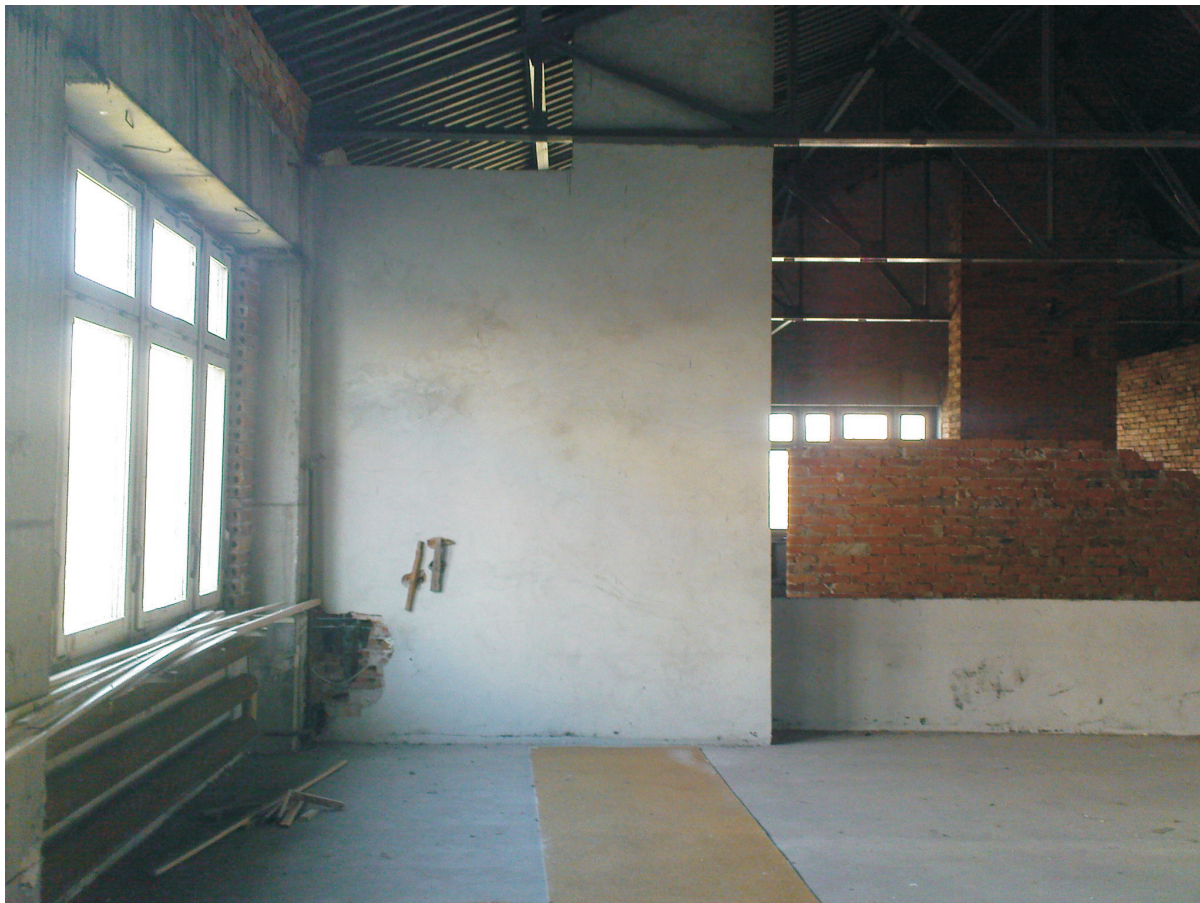
JADALNIA - WIDOK NA PRZEGRODĘ POMIĘDZY JADALNIA A KUCHNIĄ
