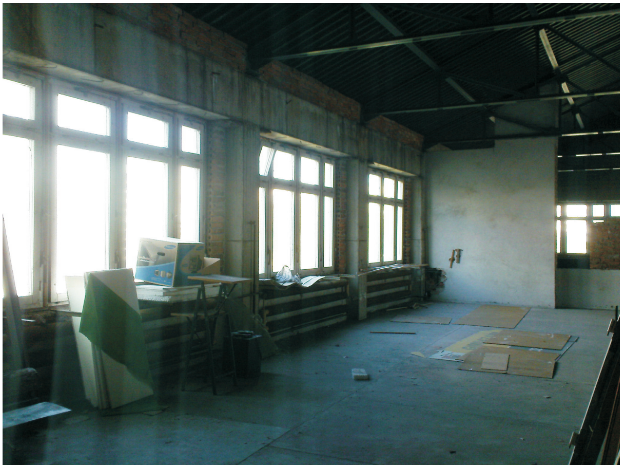
JADALNIA - WIDOK NA ŚCIANĘ W ELEWACJI ZACHODNIEJ
