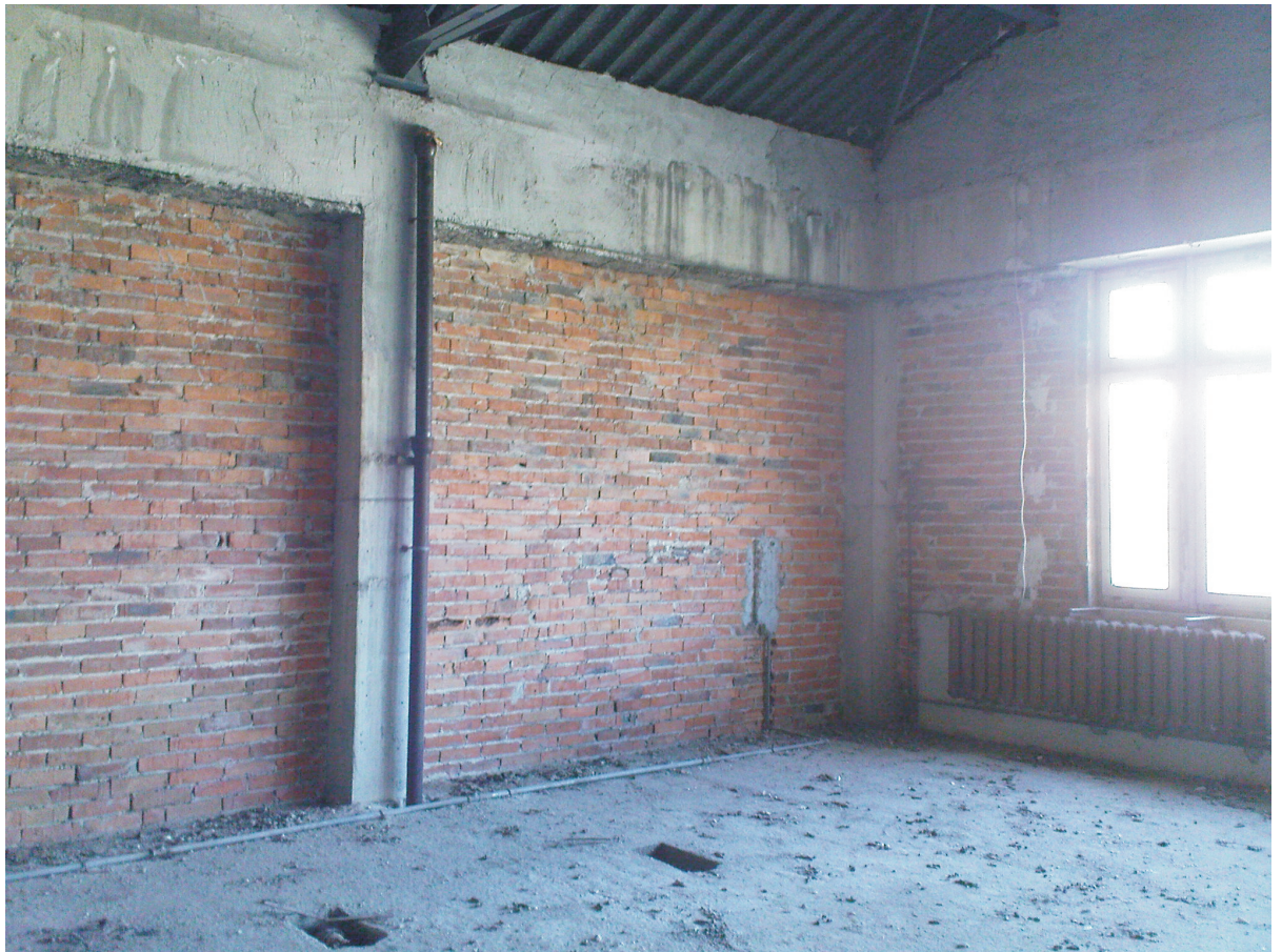
KUCHNIA -WIDOK NA ŚCIANĘ W ELEWACJI ZACHODNIEJ
