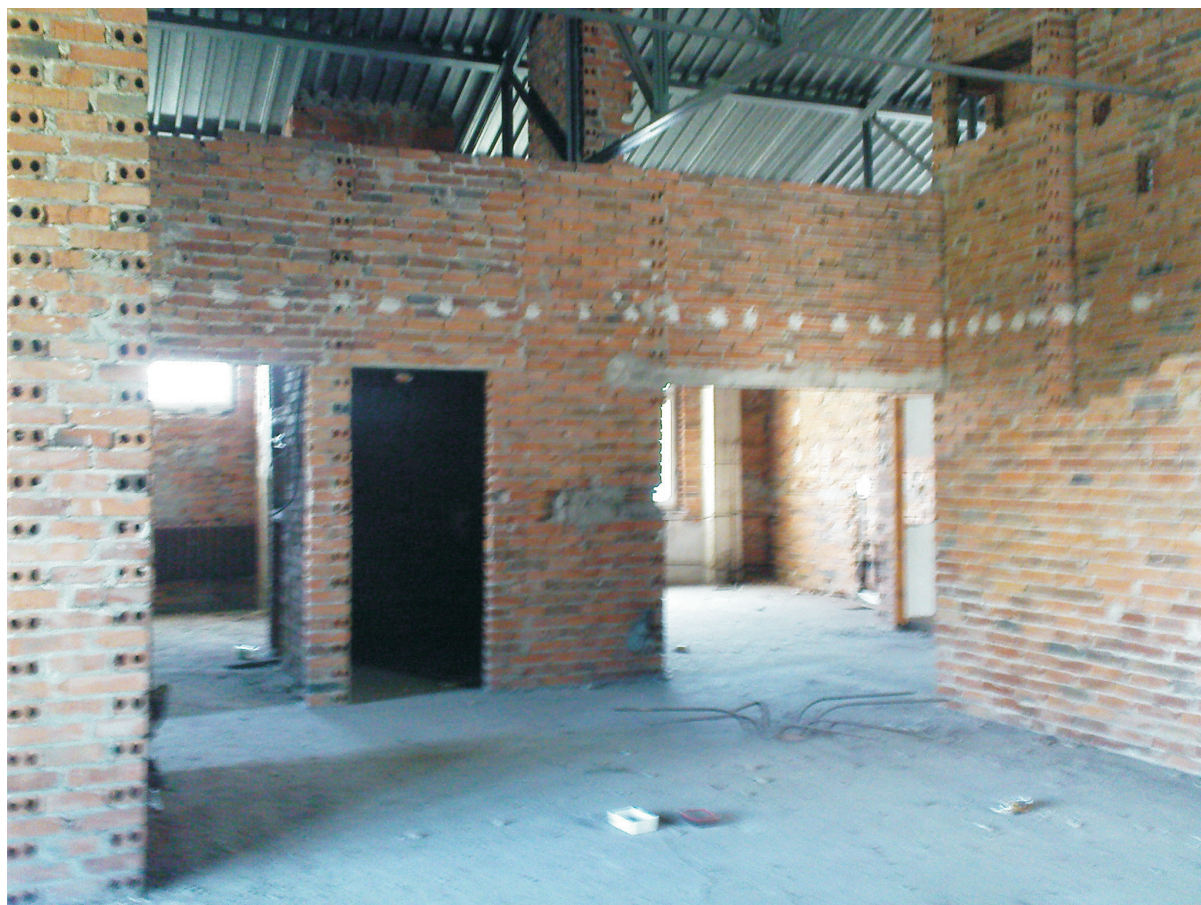
KUCHNIA - WIDOK NA MAGAZYN PODRĘCZNY I ZMYWALNIĘ
