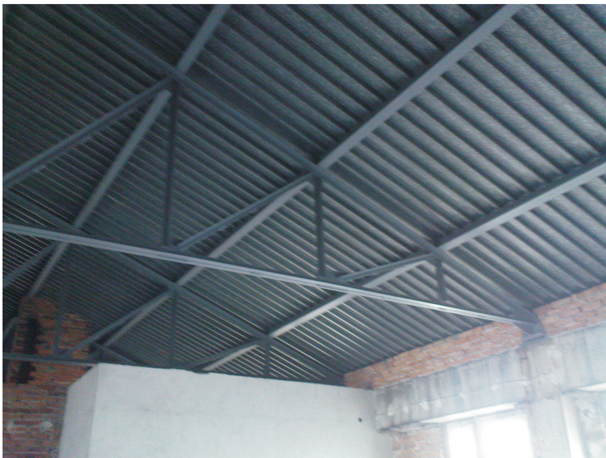
JADALNIA - WIDOK NA KONSTRUKCJĘ DACHU
