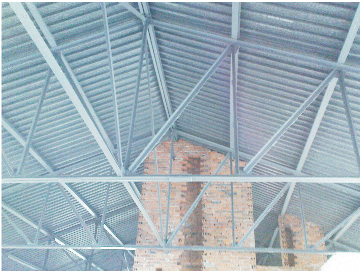
JADALNIA - WIDOK NA KONSTRUKCJĘ DACHU
