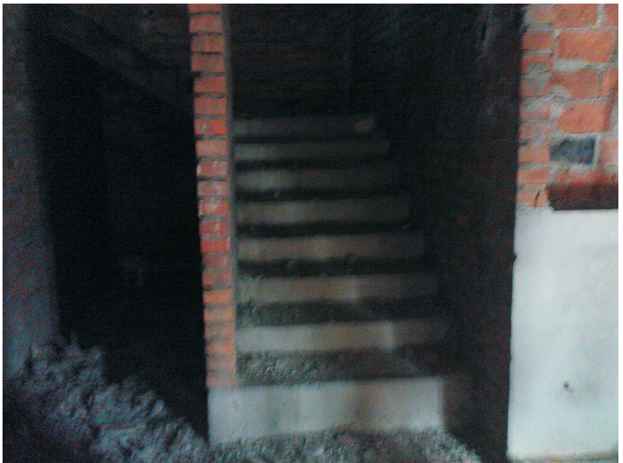
KLATKA SCHODOWA - WIDOK Z PRZYZIEMIA
