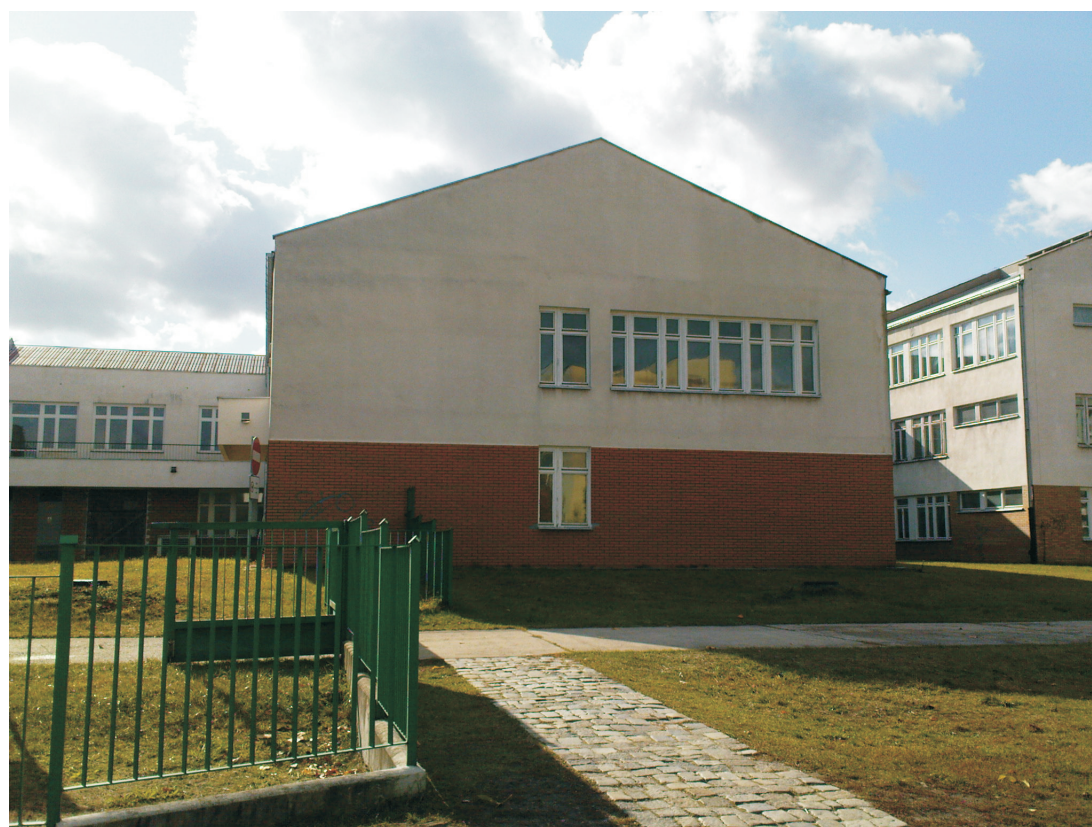
BUDYNEK ŻYWIENIOWY -WIDOK NA ELEWACJĘ PÓŁNOCNĄ
