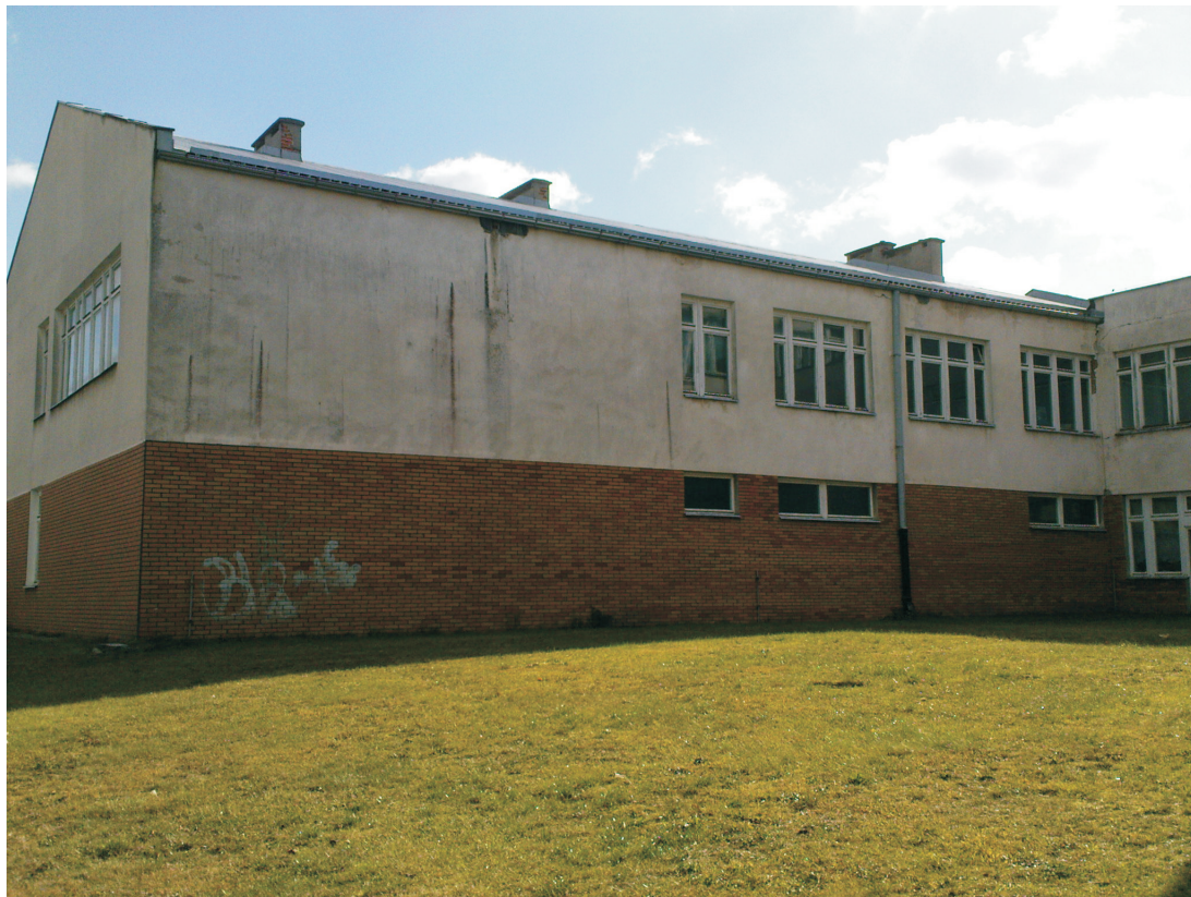
BUDYNEK ZESPOŁU ŻYWIENIOWEGO WIDOK NA ELEWACJĘ ZACHODNIĄ
